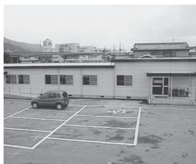
役場敷地内に設けられた 仮設事務所
